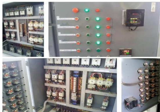
ภาพที่2 ติดตั้งชุดชอร์ฟสตาร์ทผลการประหยัด
